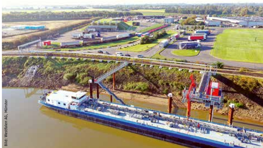
Am Caratgas-Hafentanklager der Westfalen Gruppe in Krefeld liefert ein Rheinschiff Bio-Propan an.
