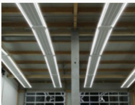
Bei einer Schrägmontage der Deckenstrahlplatten lassen sich die LED-Leuchten jetzt einfacher fixieren
