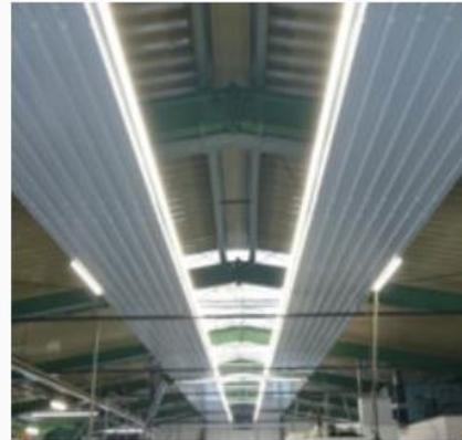
**LED-Leuchten können an den Deckenstrahlplatten flexibel eingesetzt werden – einseitig, beidseitig, einzeln oder zu Lichtbändern verbunden**
