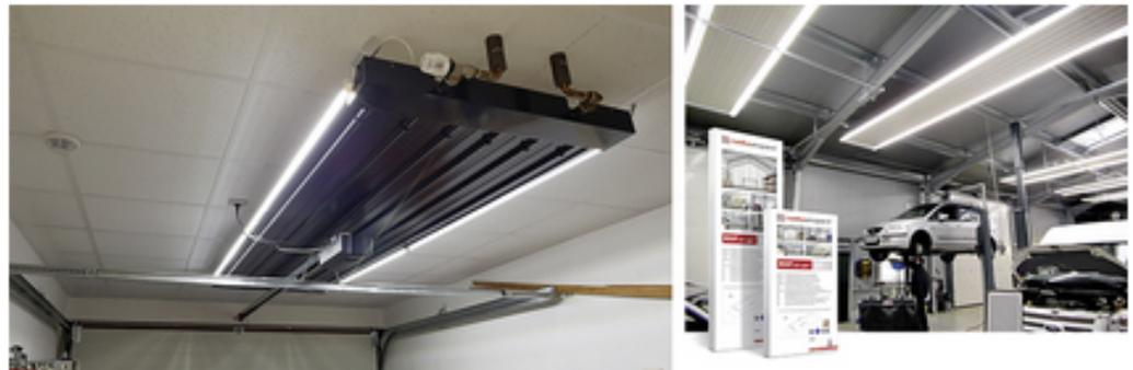
„KSP to go“: Die Lösung von RMBH kombiniert Heizung und Licht in Form von Deckenstrahlplatten und LED-Leuchten. Bilder: RMBH
